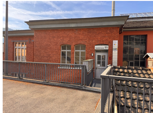
Auf der rechten Strassenseite durch die Türe von Badstrasse 11
